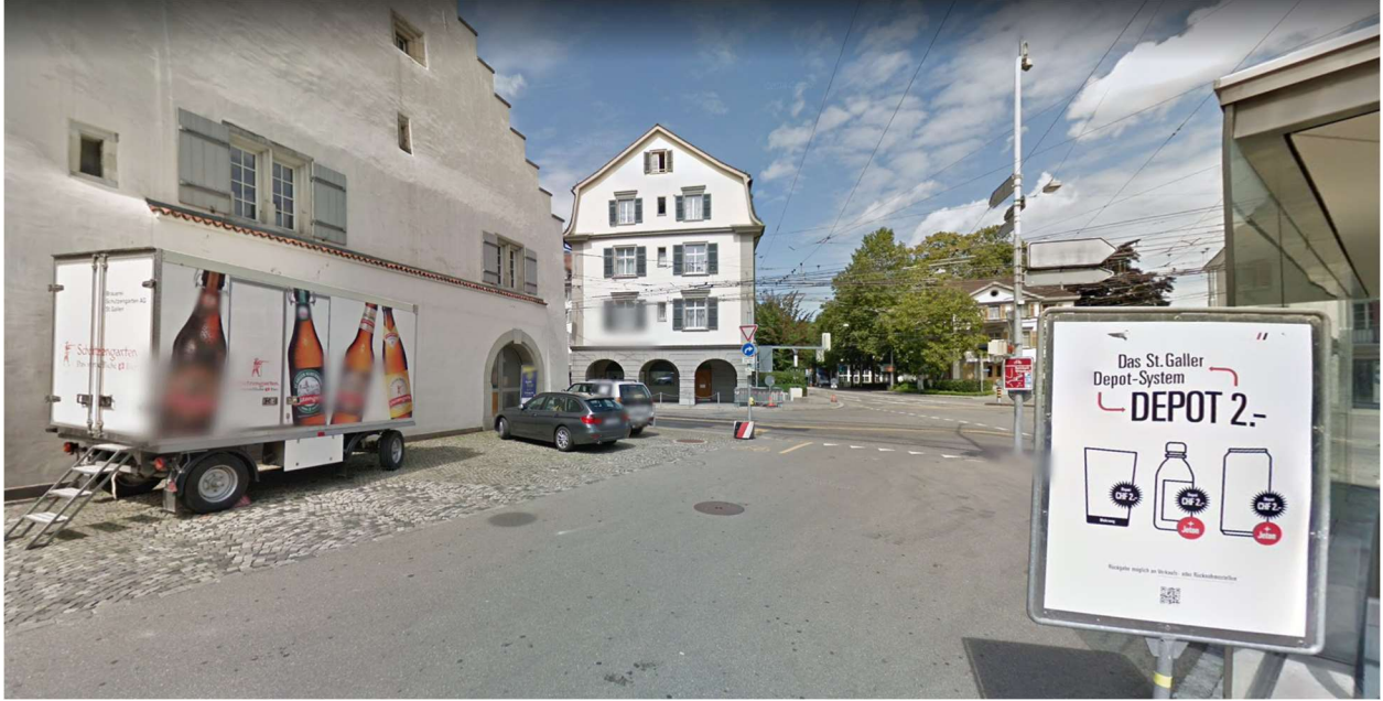
Waaghaus, St. Gallen (2014, von hinten aufgenommen)
